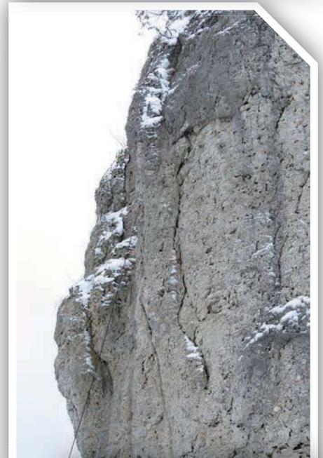
Bild 4: Schalige Verwitterung an den Flanken des Burgfelsens.
