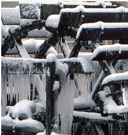
❶ Wasserschöpfrad von 1968 im Eiszapfenkleid im Januar 1985 (Photo Walter Rüfer)
