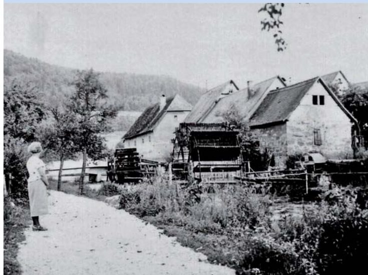
7 Wasserräder in Ebermannstadt: im Vordergrund für den Maschinenantrieb der Schmiedewerkstatt Rudolf Göller – im Hintergrund das Wasserschopfrad nach 1932 (Archiv: Christian Rösch)
